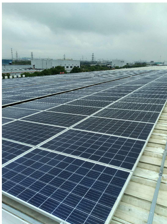
振辉三期厂房 3#直流电缆组串安装 组件到货
