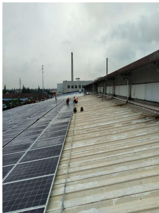
振辉三期厂房 3#组件安装
