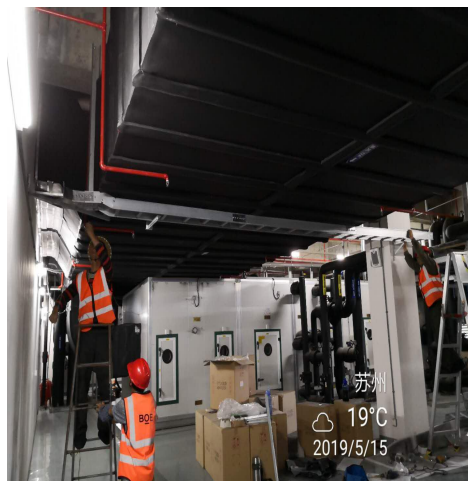
3, 4 号并网点室内安装桥架
