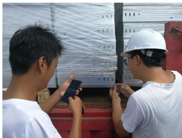
桥架进场检验
