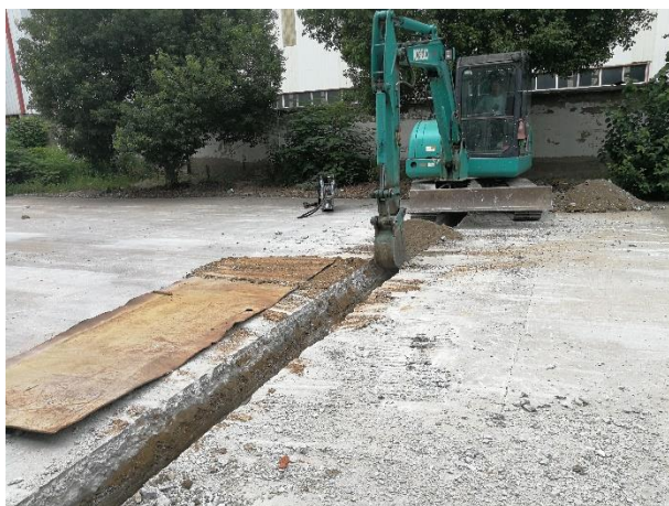
过路管道沟槽开挖
