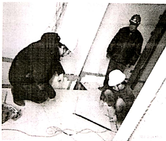
升压站继保室静电地板安装
