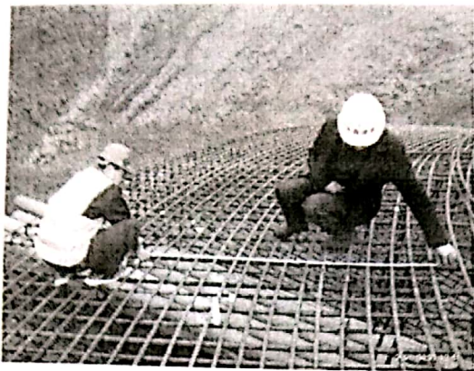
17#风机基础钢筋绑扎监理检查
