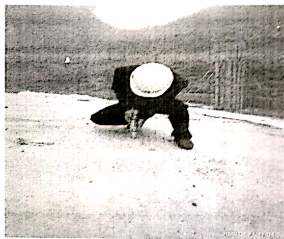
监理测试 18#风机混凝土强度
