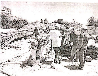
监理检查钢筋制作情况
