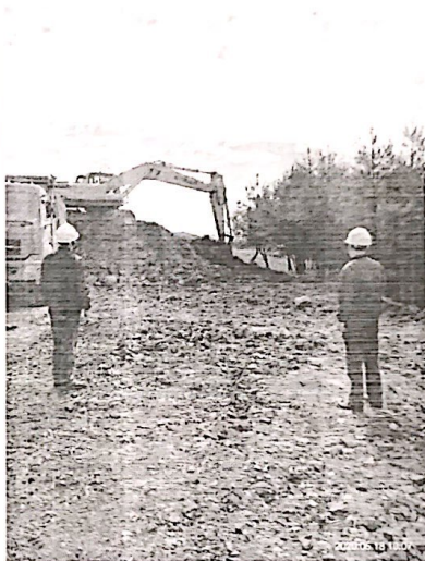
14#风机位进场道路土方开挖
