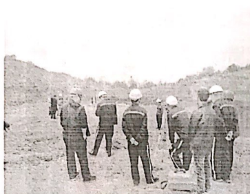
华能监检中心专家检查施工现场
