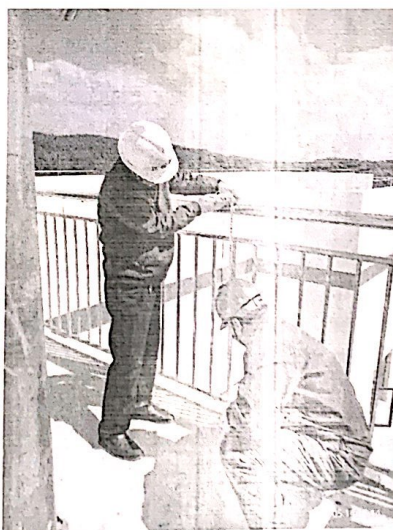
监理检查验收屋面安装护栏规格型号
