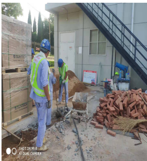
预制舱基础施工
