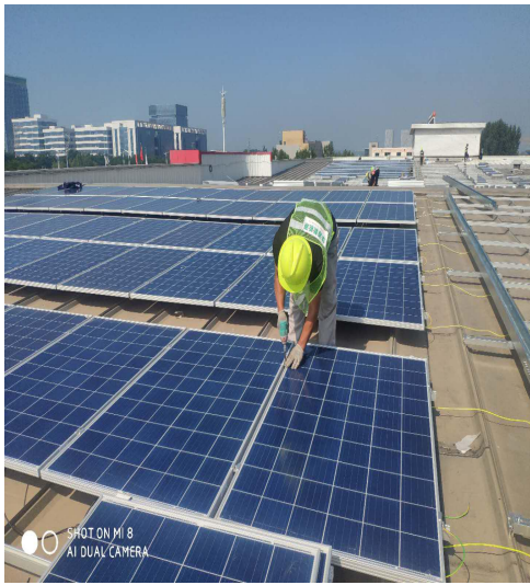
一期屋面组件安装
