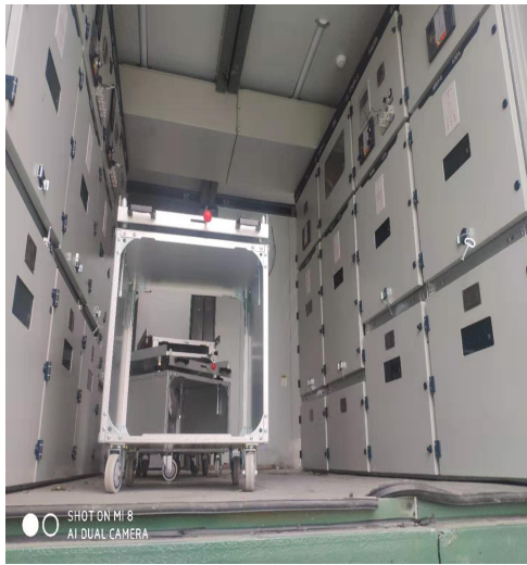
预制舱部分设备安装
