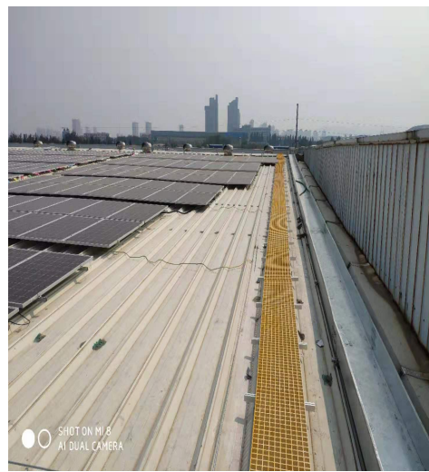
二期厂房走道安装
