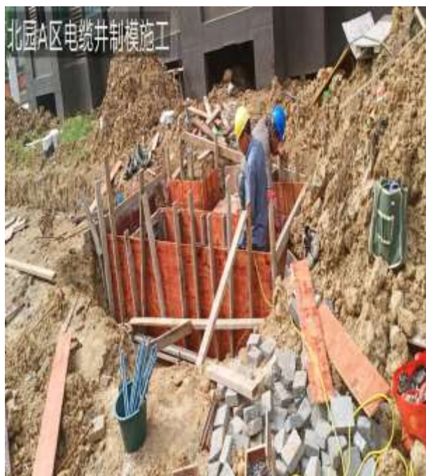
电缆井制模施工
