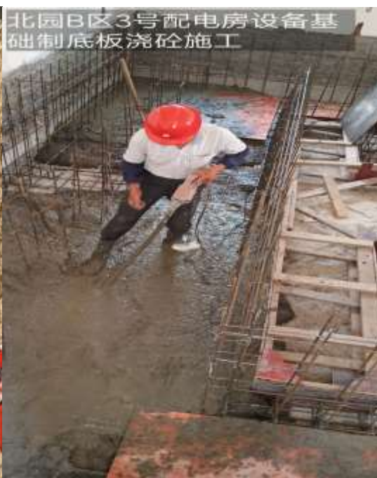
设备基础制底板浇筑施工
