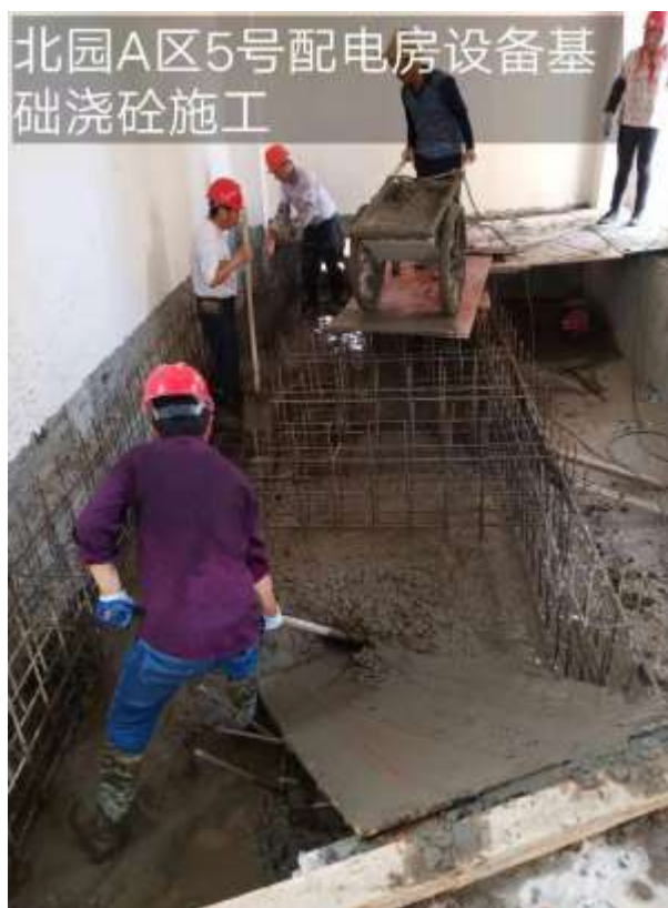
北园 A 区 5 号配电房设备基础浇砼施工
