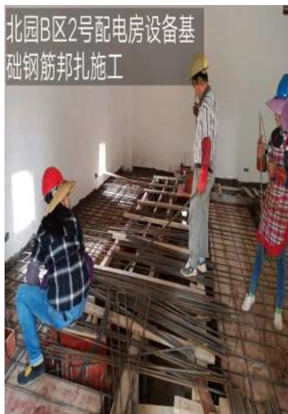
北园 B 区 2 号配电房设备基础钢筋绑扎施工
