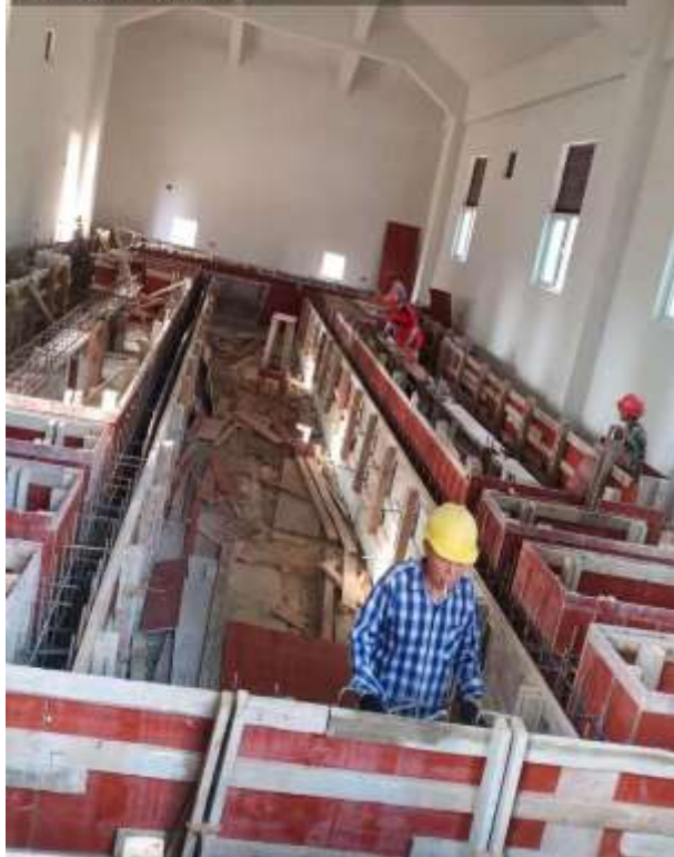
北园 A 区 4 号配电房设备基础制模施工
