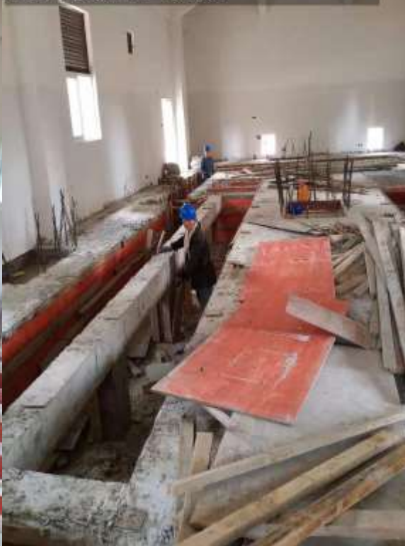
北园 A 区 1 号配电房设备基础拆模施工
