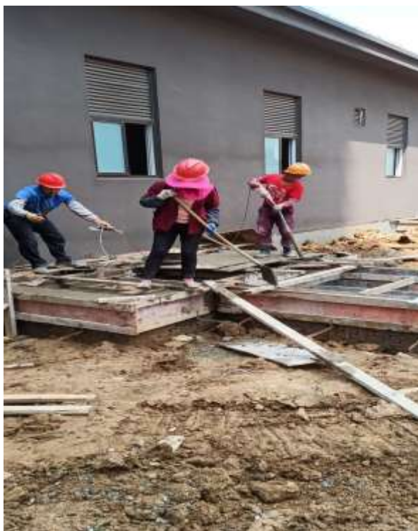
北园 A 区电缆沟浇砼施工
