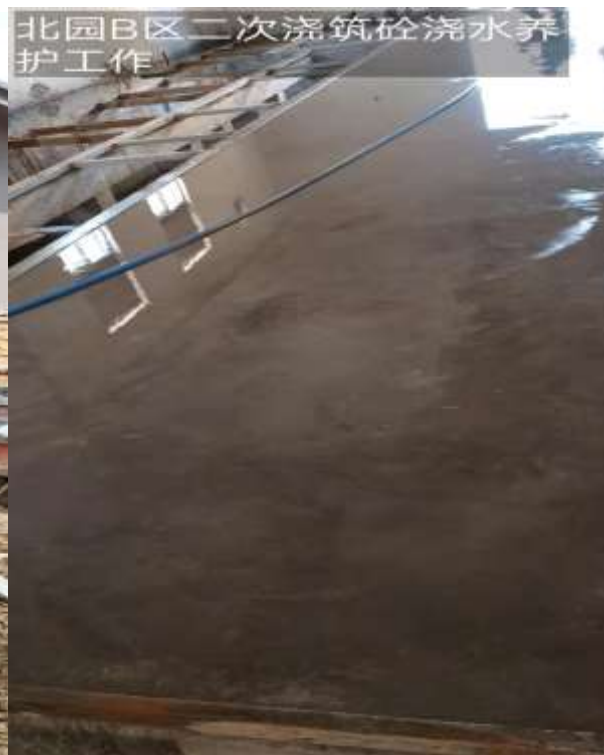
北园 B 区二次浇筑砼浇水养护工作
