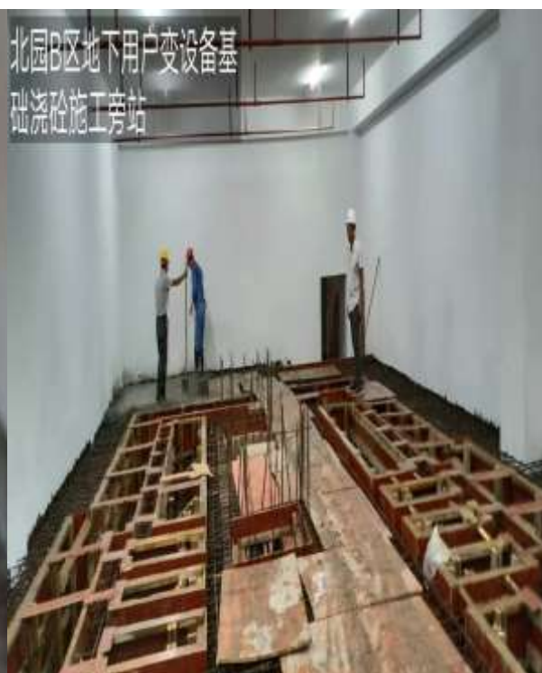
北园 B 区地下用户变设备基础浇筑砼施工旁站
