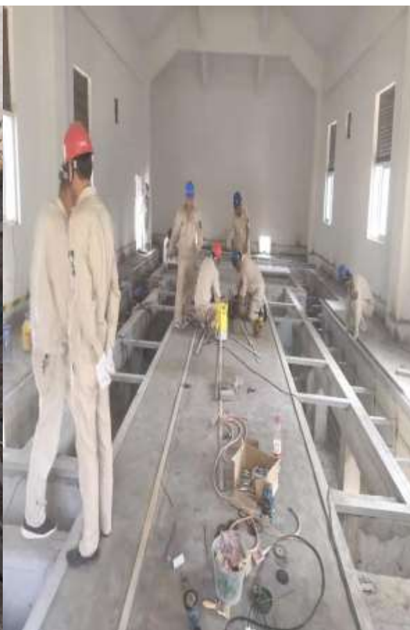
北园 A 区配电房接地焊接施工
