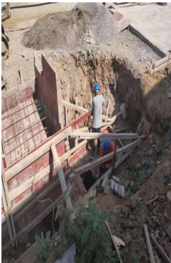
北园 B 区电缆沟砼浇筑
