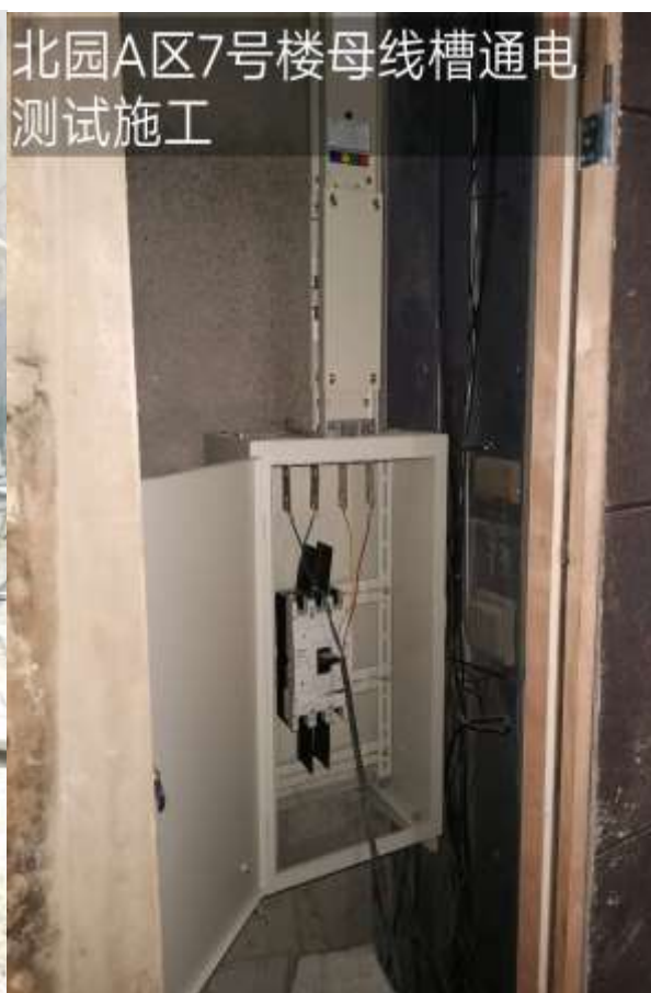
北园 A 区 7 号楼母线槽通电测试施工
