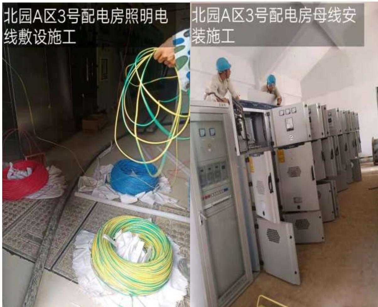
北园 A 区 3 号配电房照明电缆敷设施工
