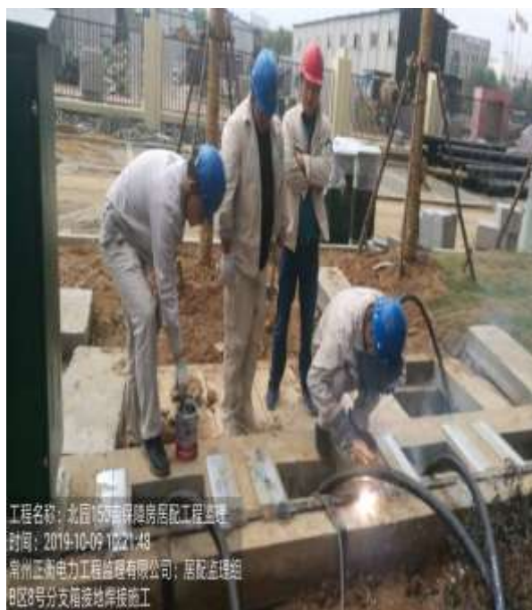
B 区 8 号分支箱接地焊接施工
