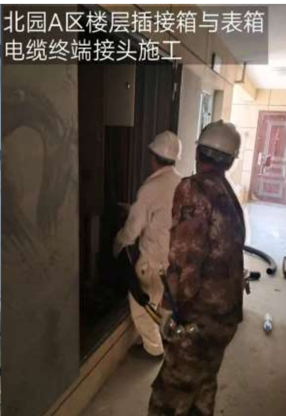
北园A区楼层夹层电缆终端接头施工
