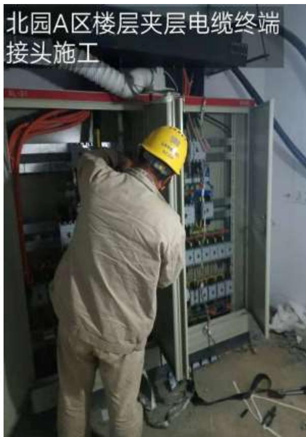
北园A区楼层插接箱与表箱电缆终端接头施工
