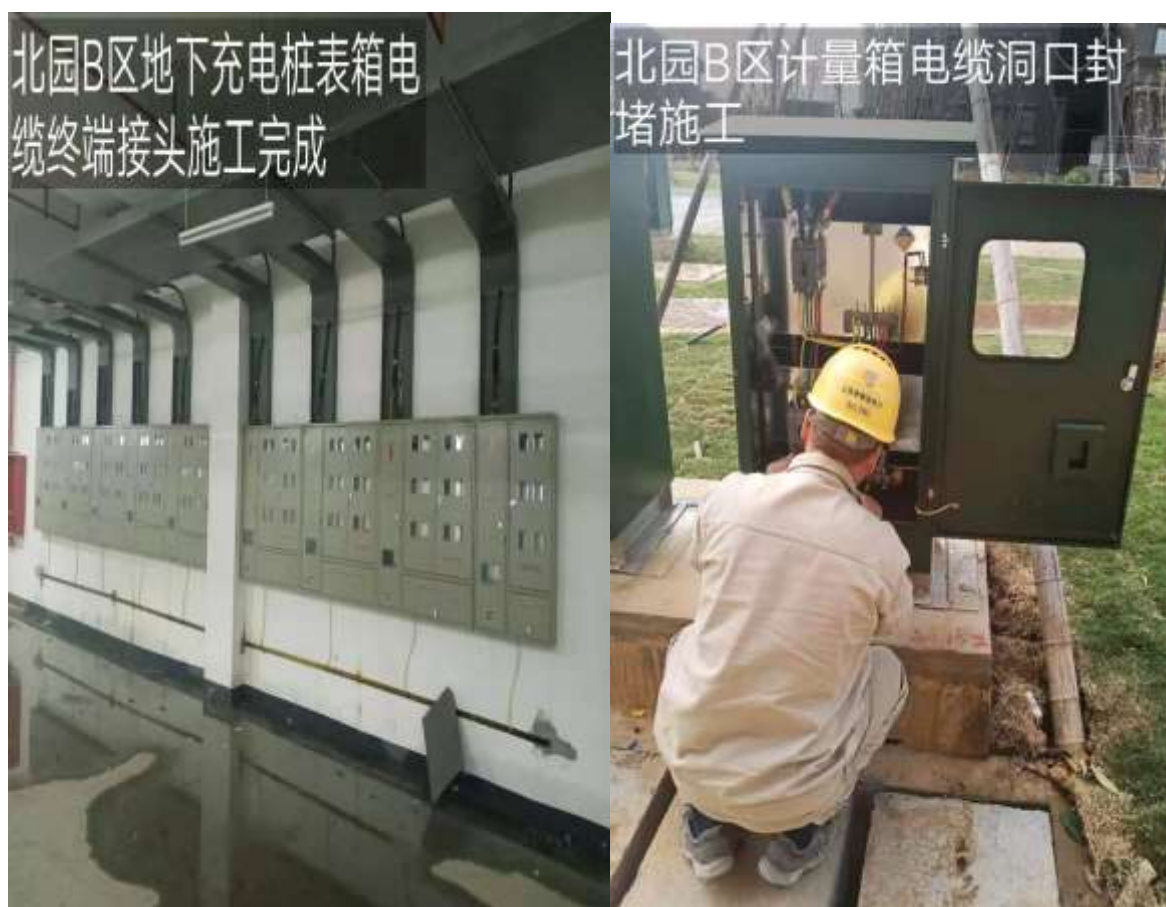
北园 B 区地下充电桩表箱电缆终端接头施工完成
