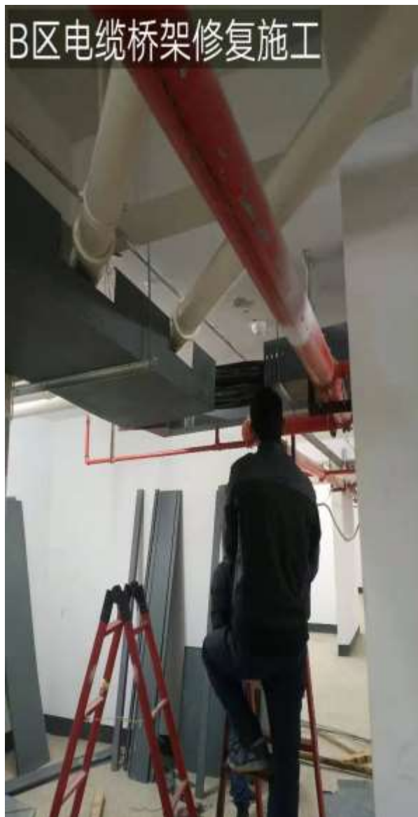
北园 B 区电缆桥架修复施工
