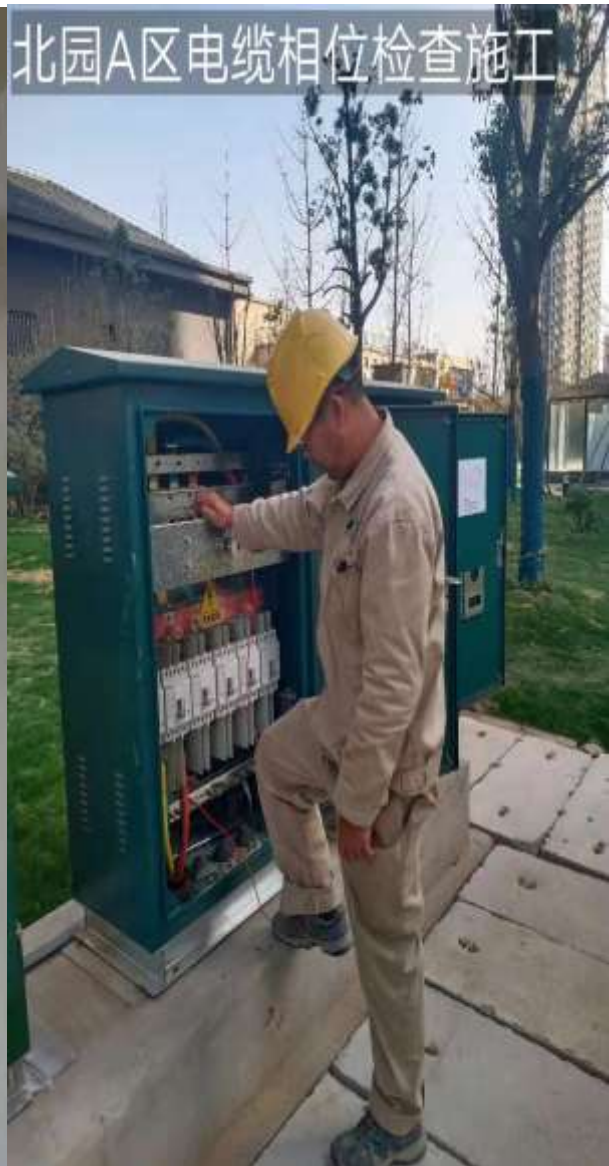
北园 A 区电缆相位检查施工
