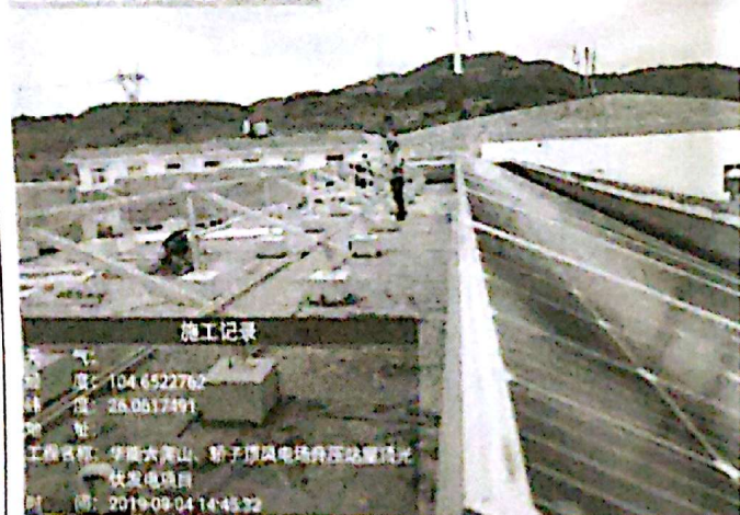
主变室安装支架横梁
