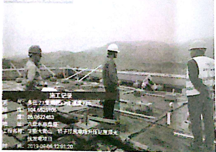
生活楼安装支架
