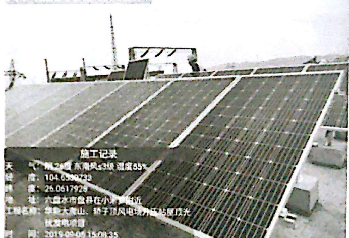
开关室安装支架横梁
