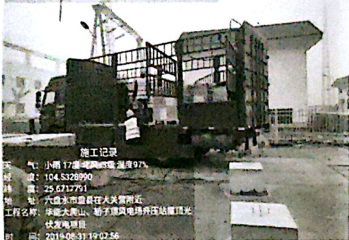
大爬山风电场升压站组件卸货
