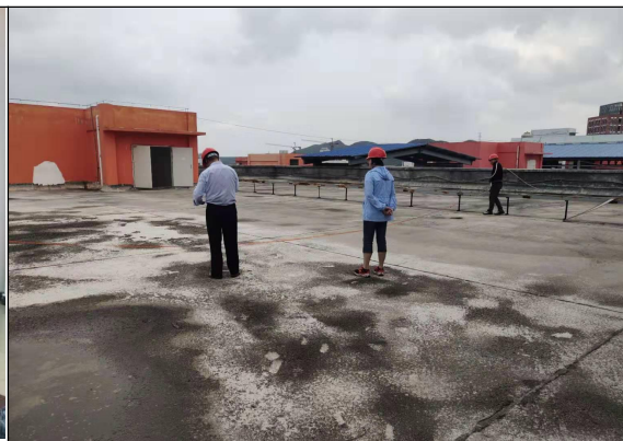
检查桩基点位
