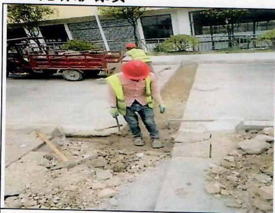
过路恢复路面
