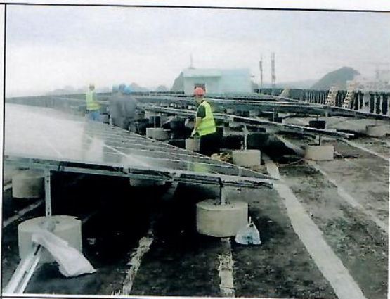
支架、组件安装
