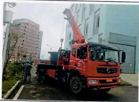
高压电缆敷设
