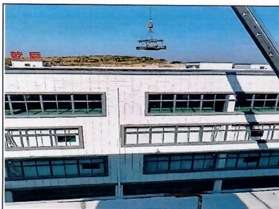
吊装支架基础
