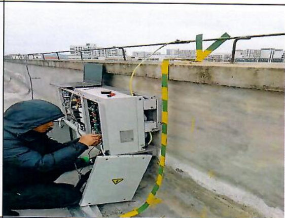
逆变器通讯设备调试
