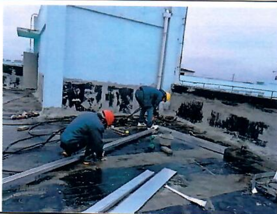
电缆槽盒安装
