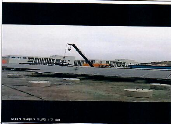
支架基础吊装
