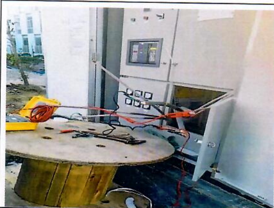
电缆绝缘测量
