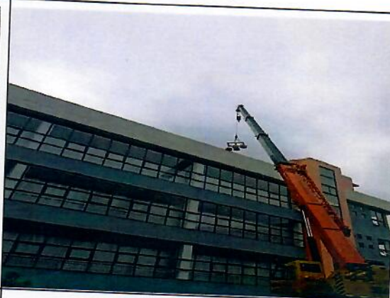
吊装支架基础
