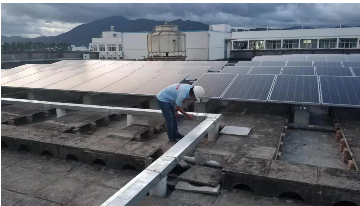
接地焊接检查
