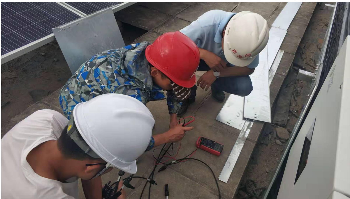
桥架安装检查
