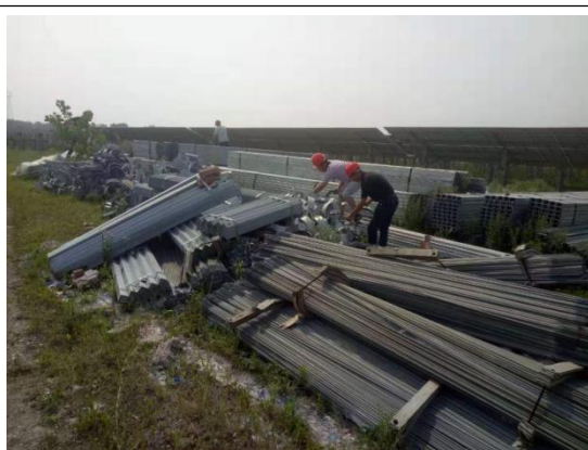
现场施工照片
