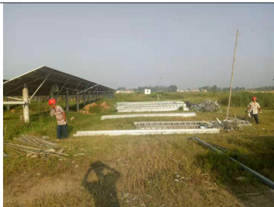
现场施工照片
