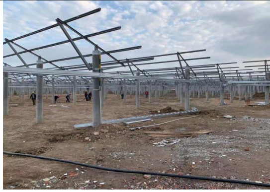
现场施工照片
