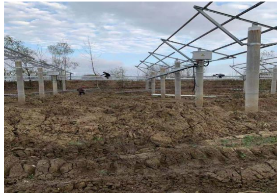
现场施工照片
