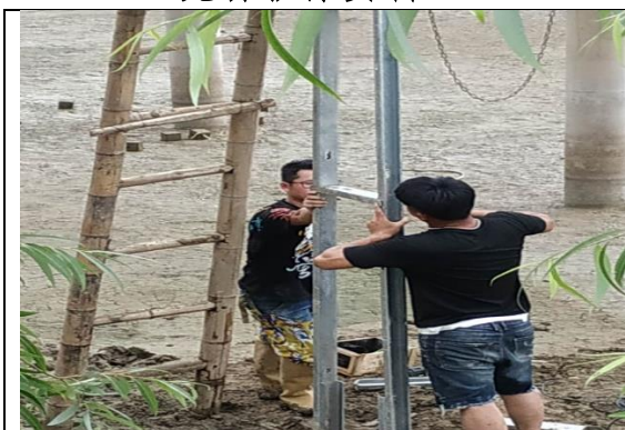
桥架整改照片
