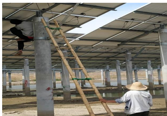
现场整改照片
