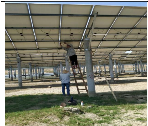
组件整改照片
