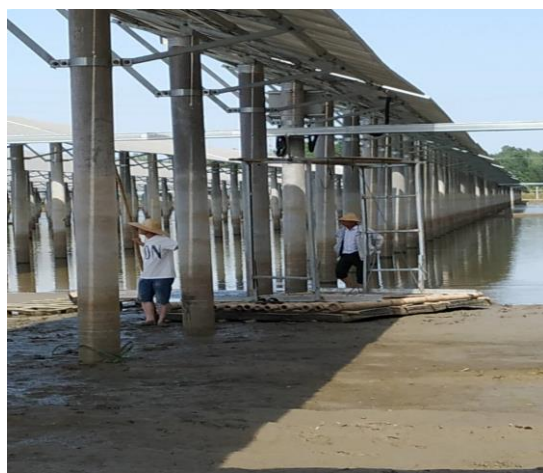
现场检查照片
