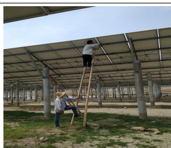
组件整改照片
