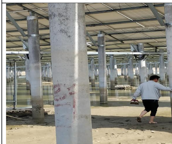
组件整改照片
