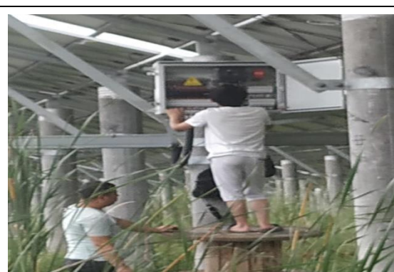
汇流箱维修照片
