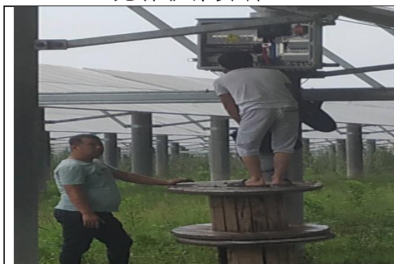
汇流箱维修照片
