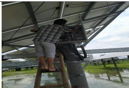
汇流箱维修照片
