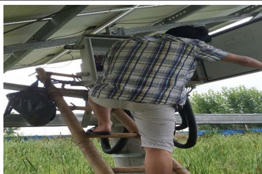
汇流箱维修照片
