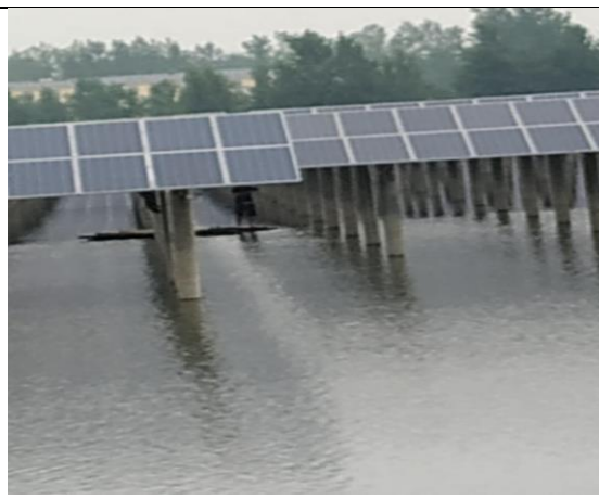
组件整改照片
