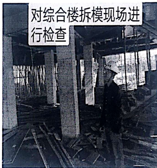
图 2：对综合楼拆模现场进行检查
