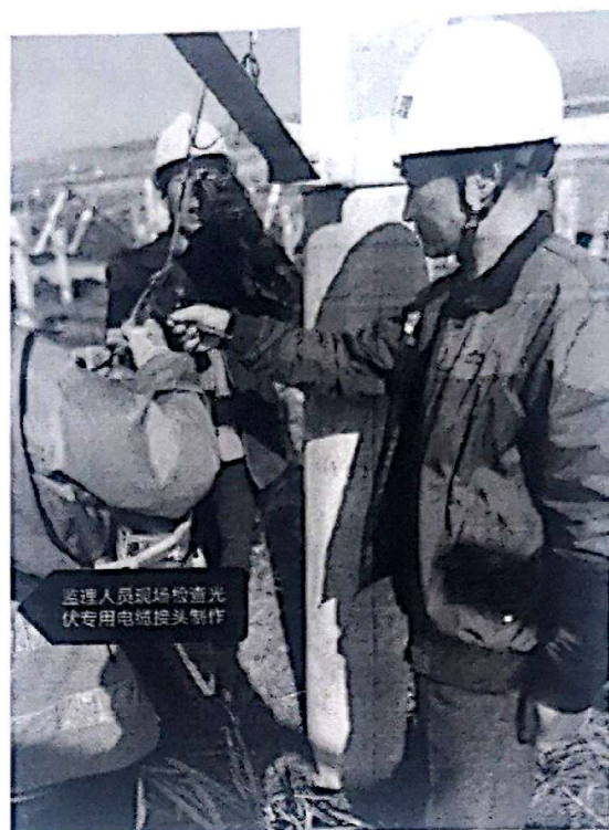
图 12：监理人员现场检查光伏专用电缆接头制作
