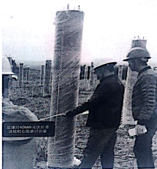
图 4: 监理对 40MW 光伏区灌注桩桩心距进行测量
