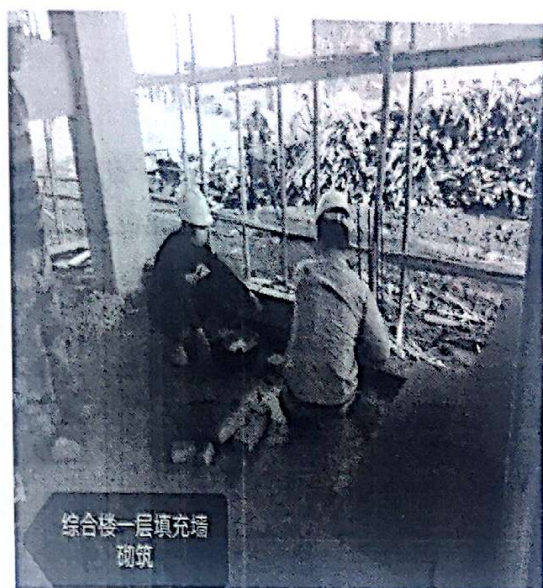
图 3: 综合楼一层填充墙砌筑
