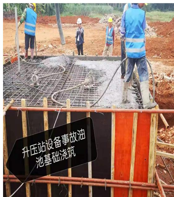
图 2：升压站设备事故油池基础浇筑
