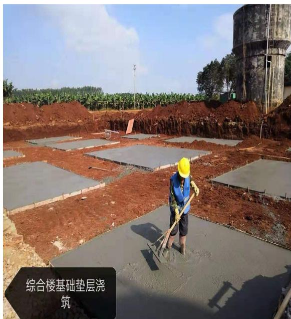
图 1：综合楼基础垫层浇筑
