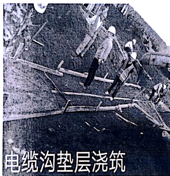
图 7: 电缆沟垫层浇筑
