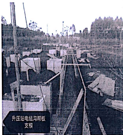
图 2：升压站电缆沟帮板支模
