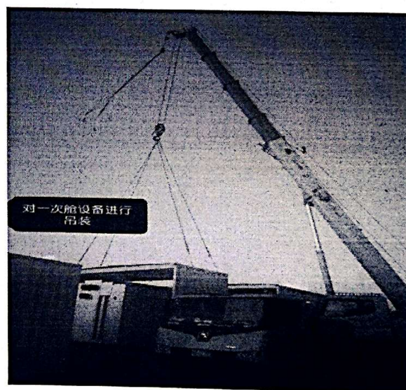
图 4：对一次舱设备进行吊装
