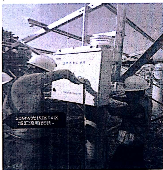
图 7: 20MW 光伏区 9#区域汇流箱安装
