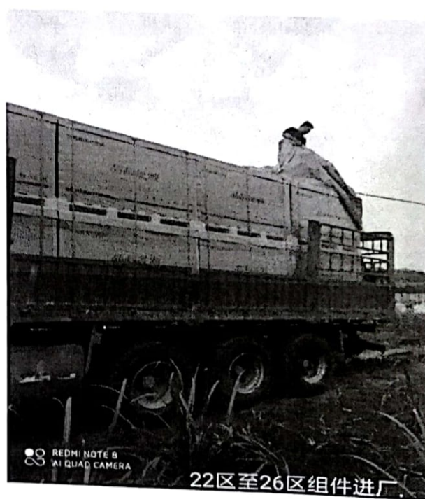
图 4: 晶科光伏组件进场
