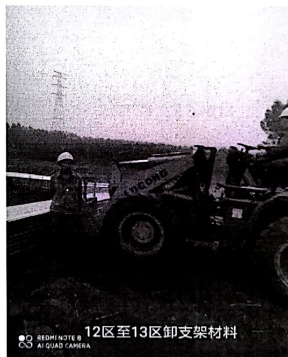
图 8：材料光伏支架进场
