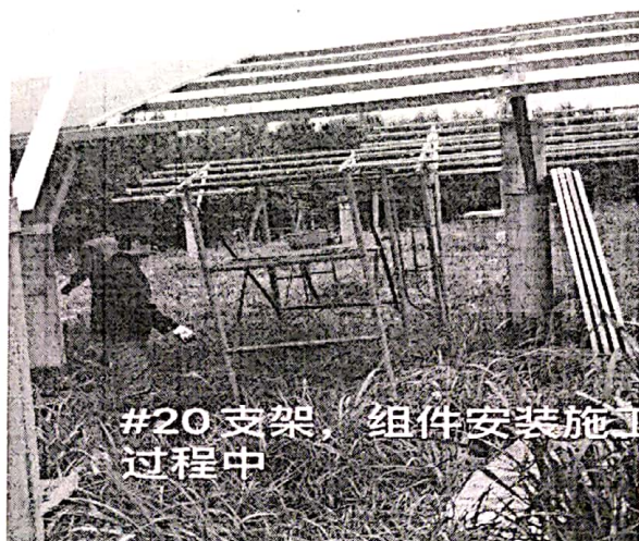
图 5: 20 区支架安装现场
