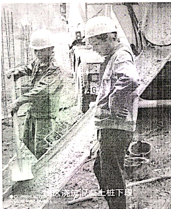
图 3：10 区灌注桩浇筑现场
