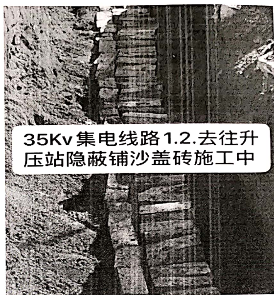
图 10: 集电线路电缆沟铺沙盖砖
