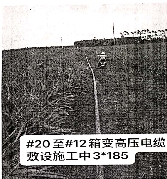
图 9: 3*185 高压电缆敷设#20 到#12 区箱变
