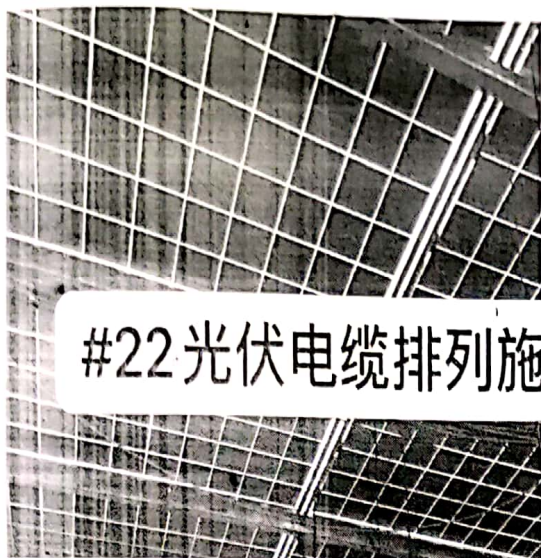
图 9: 22 区 1*4 光伏电缆施工
