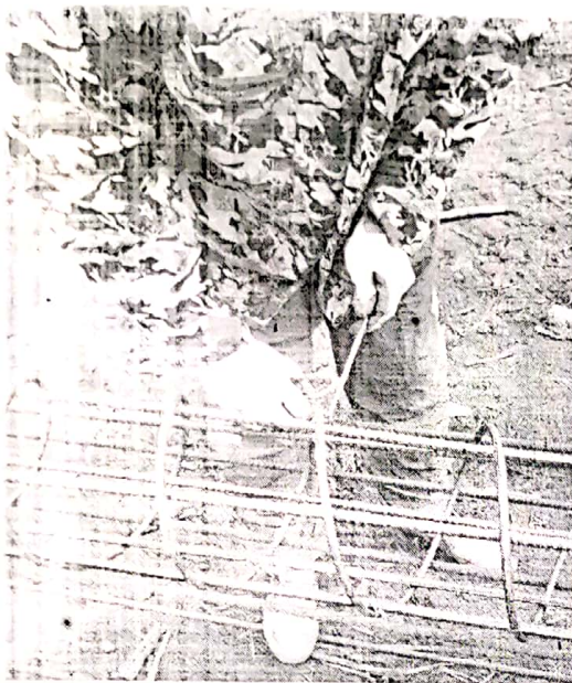
图 1：现场制作钢筋笼
