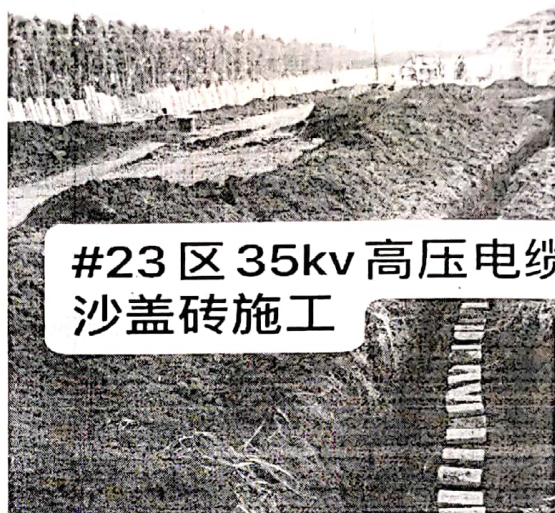
图 2：高压电缆敷设中
