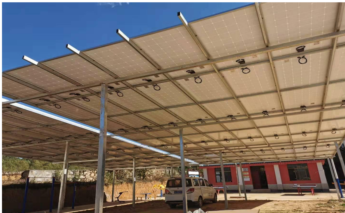
落水洞村组件安装完成
