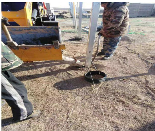
现场施工照片
