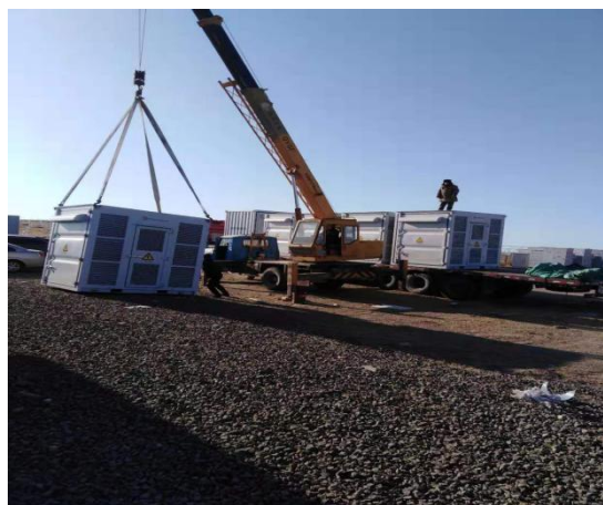
现场施工照片
