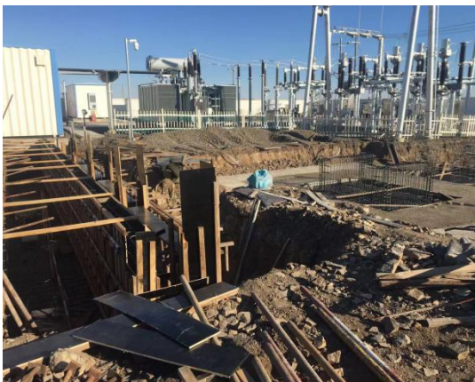
现场施工照片
