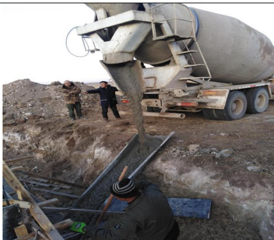
现场施工照片
