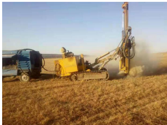
现场施工照片
