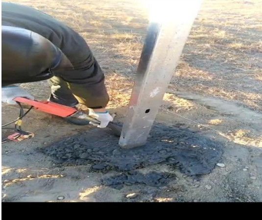
现场施工照片
