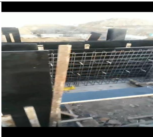
现场施工照片
