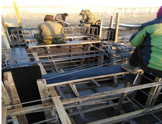
现场施工照片
