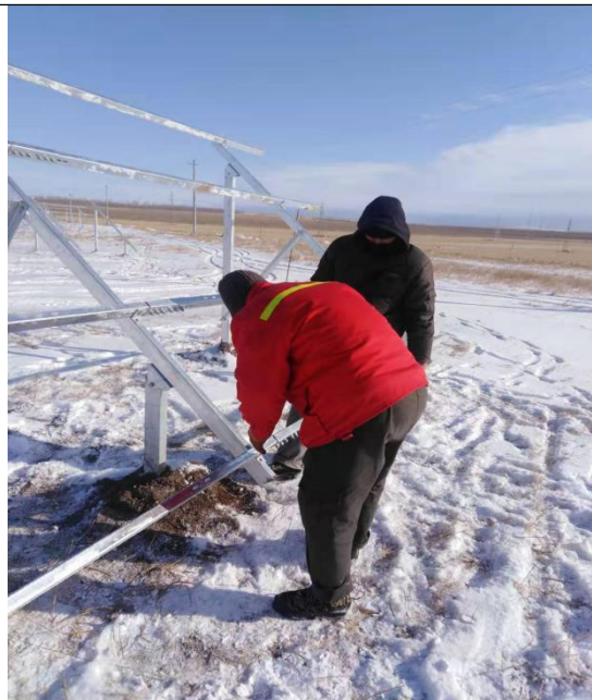
现场施工照片
