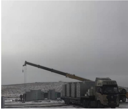
现场施工照片
