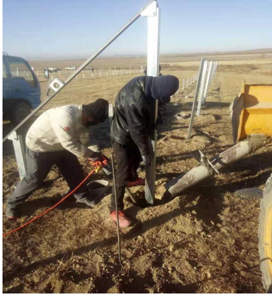
现场施工照片
