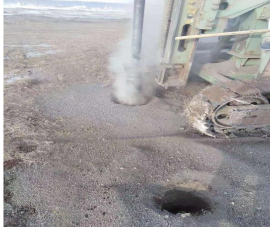
现场施工照片
