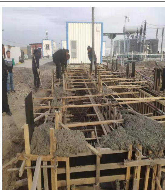
现场施工照片
