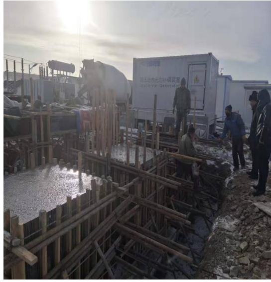
现场施工照片
