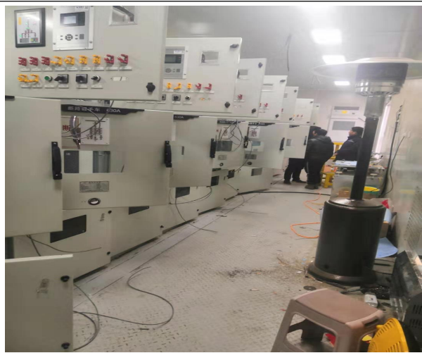
现场施工照片
