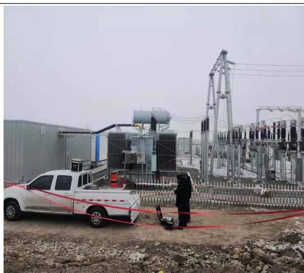
现场施工照片
