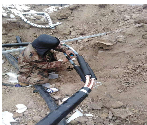
现场施工照片
