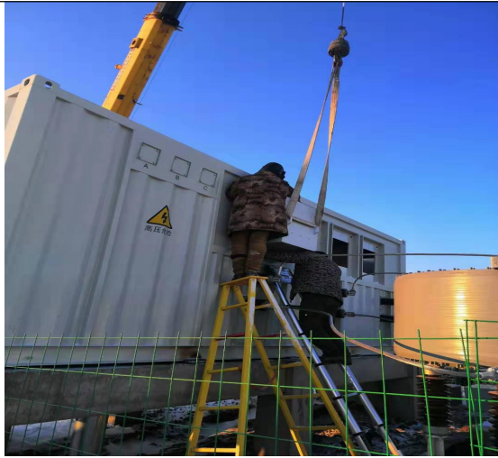
现场施工照片
