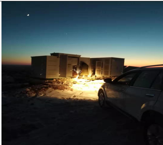
现场施工照片
