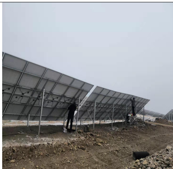
现场施工照片
