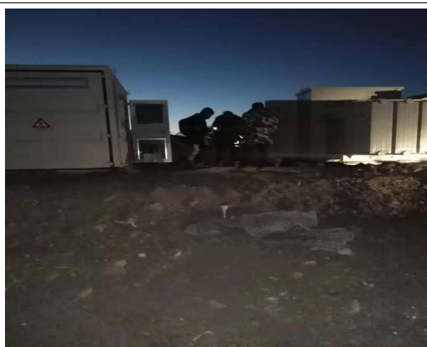
现场施工照片
