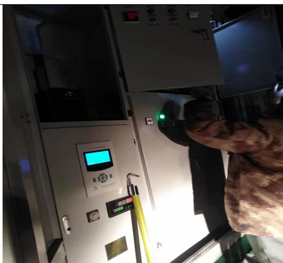
现场施工照片
