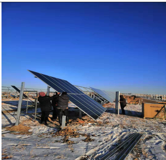
现场施工照片
