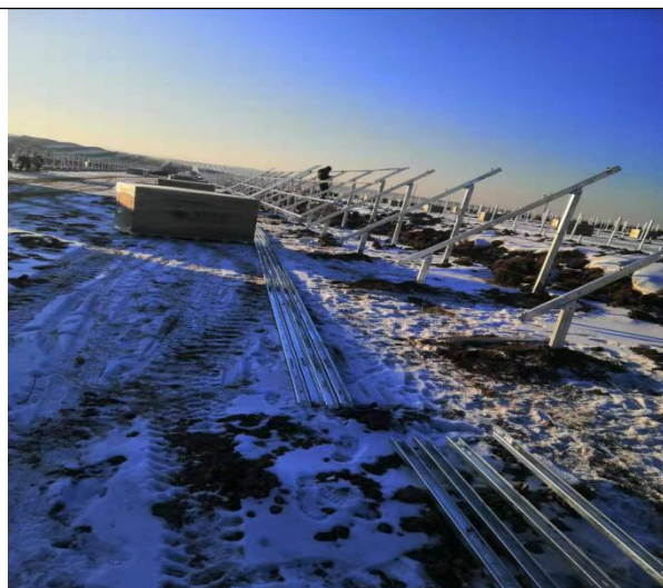
现场施工照片
