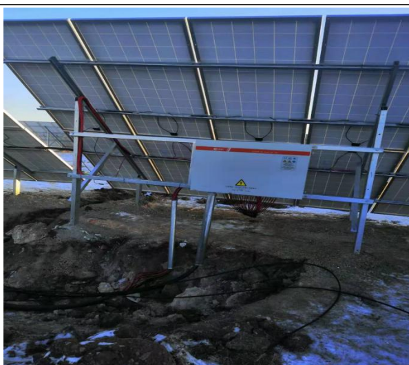
现场施工照片
