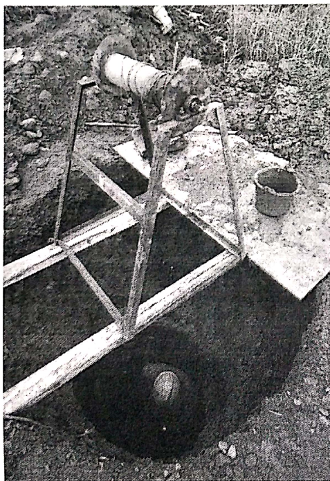
1#塔基基础挖掘整改施工
