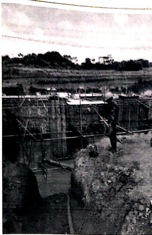
5#塔基基坑抽排水
