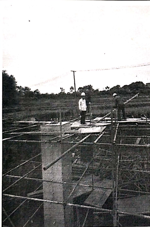
监理人员巡视检查
