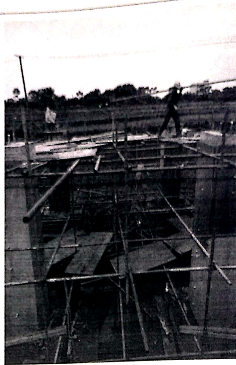
5#塔基基础拆模
