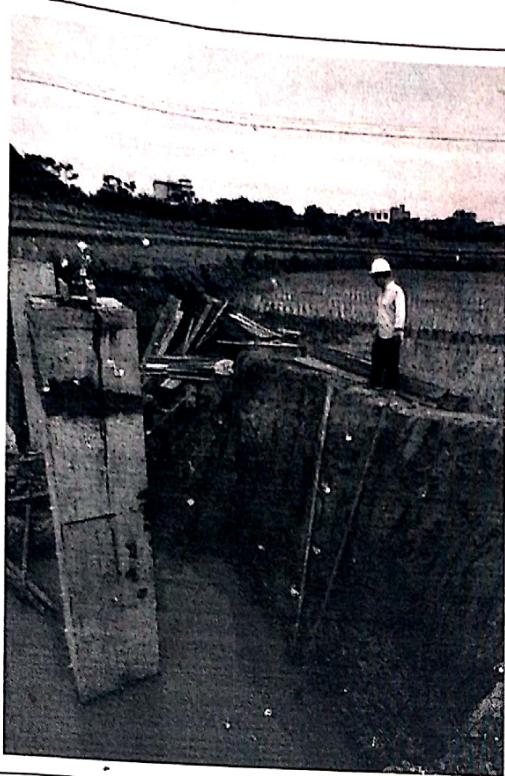
监理单位巡视检查
