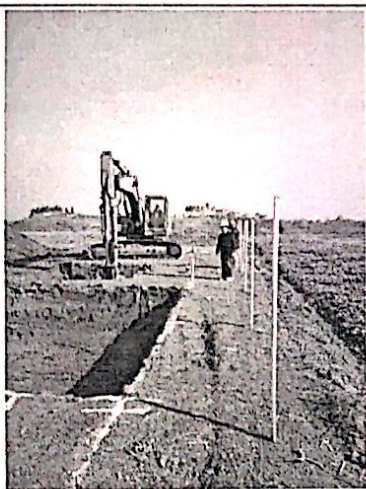
SVG 基础开挖
