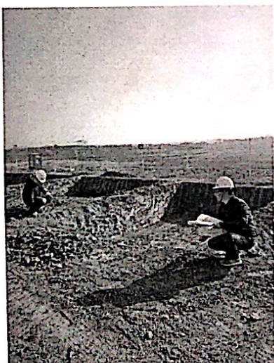
开关站基础验槽
